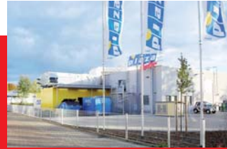
Links Ansicht Eingangsbereich
